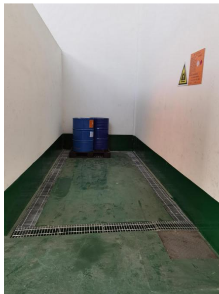
图 4.1-20 南厂区危废仓库内部情况
