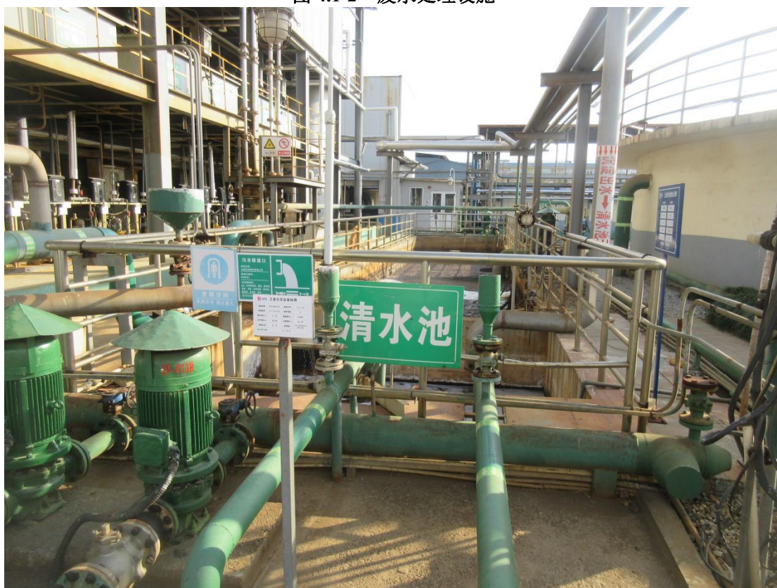
图 4.1-3 污水站废水排放口
