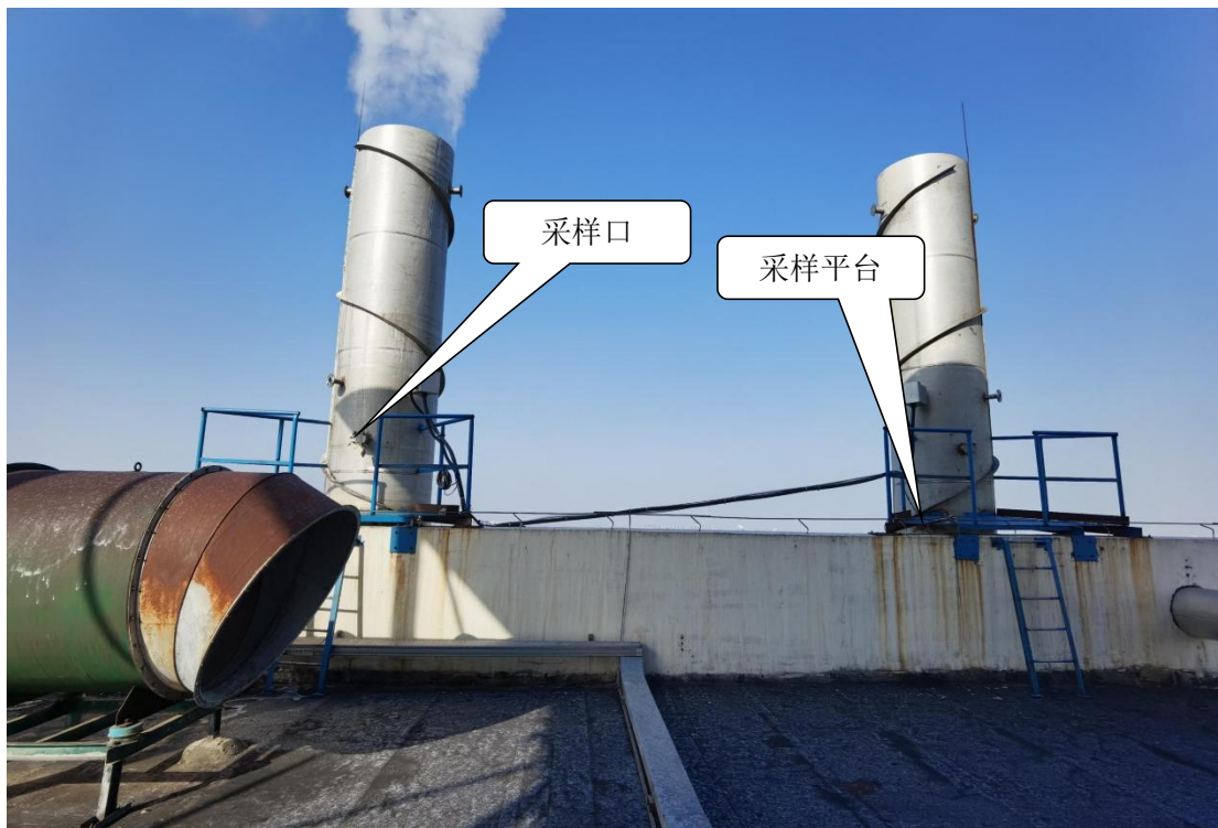
图 4.1-124、5 号线碱喷淋处理设施排气筒
