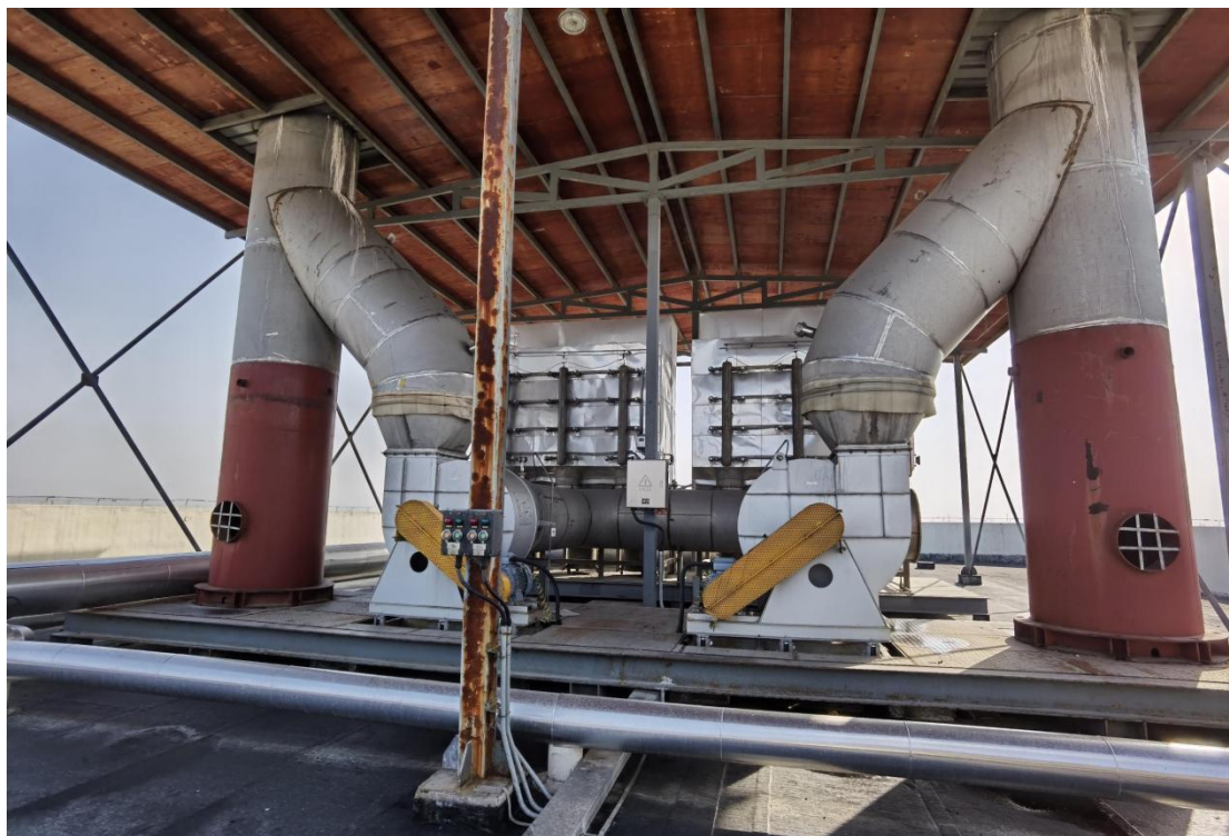
图 4.1-114、5 号线布袋除尘+高效过滤处理设施
