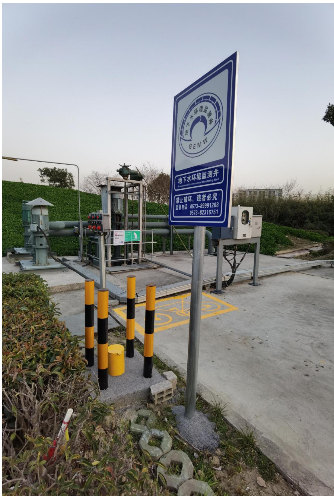
图 4.2-3 地下水监测井
