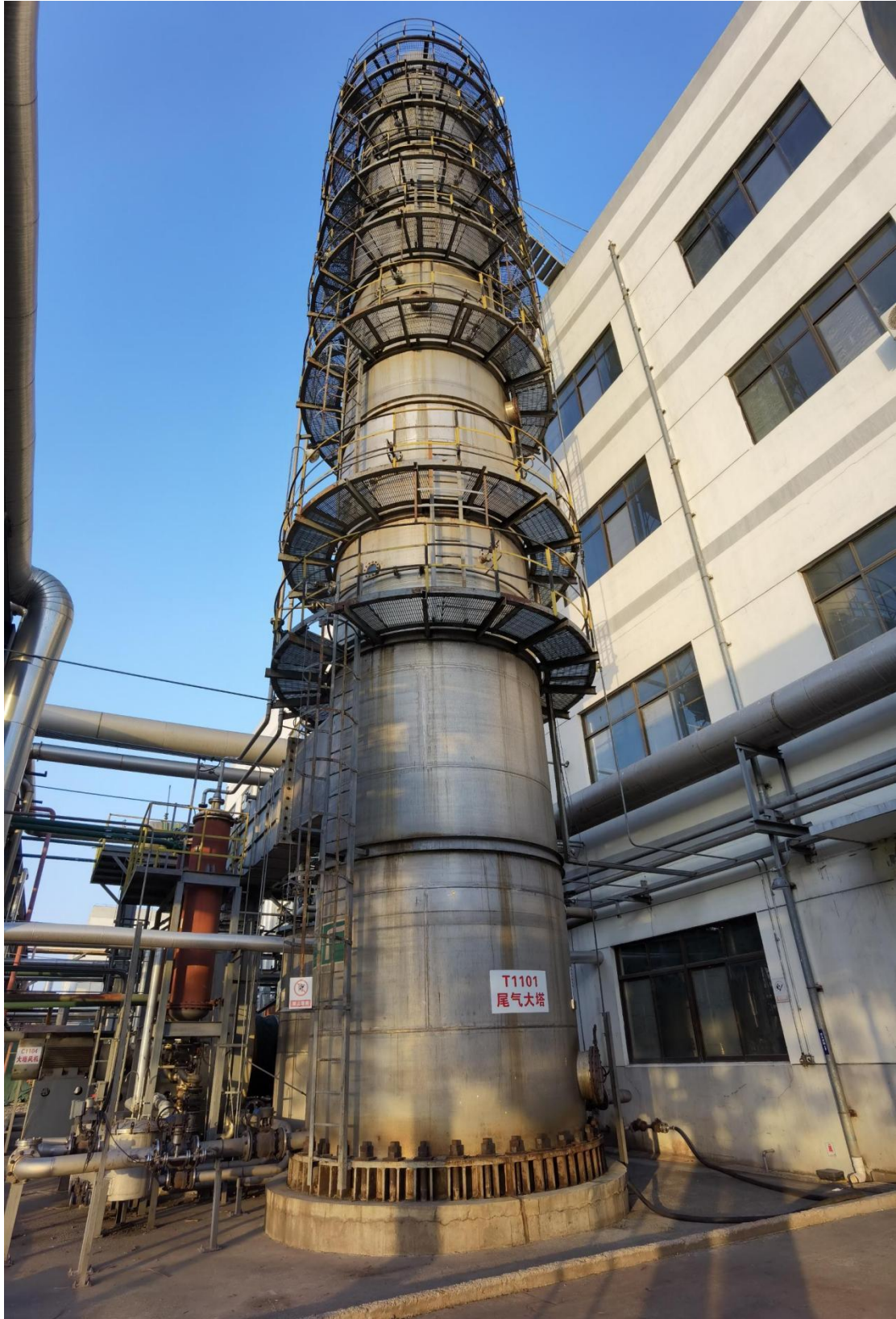
图 4.1-13 一期碱喷淋处理设施排气筒
