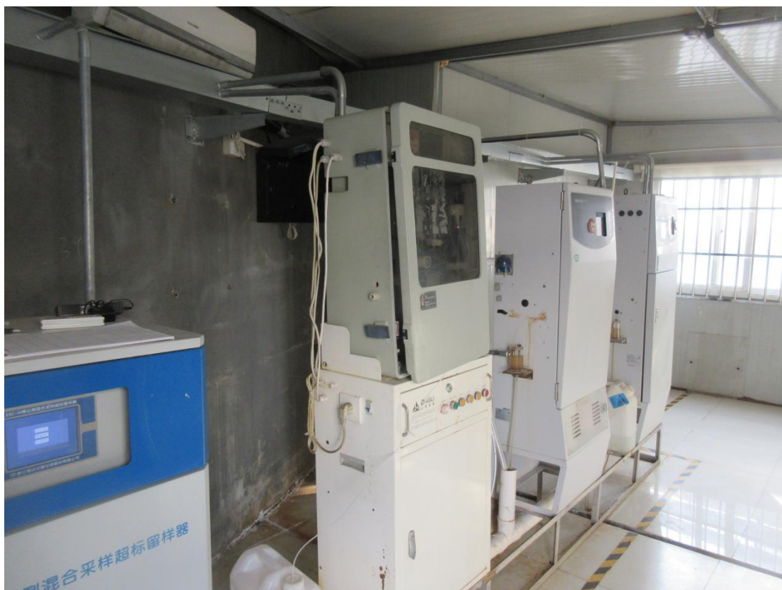
图 4.1-4 废水在线监测设施
