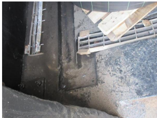
图 4.1-16 西厂区危废仓库导排沟
