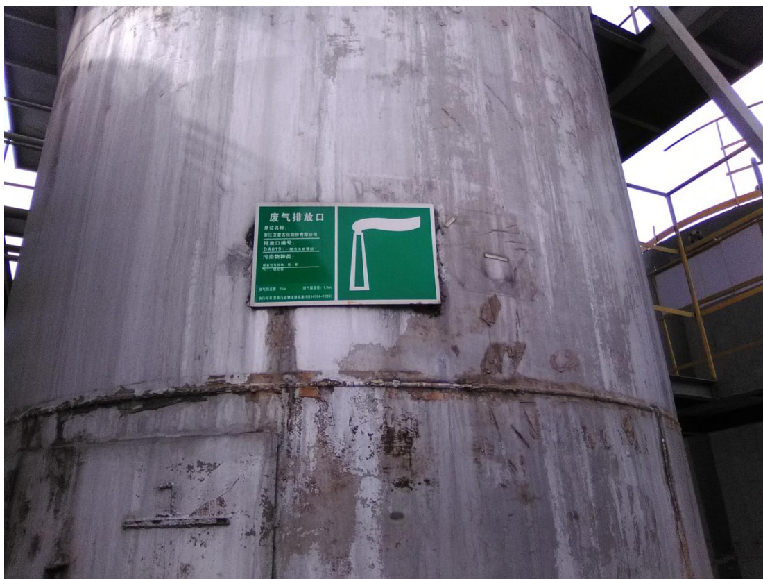
图 4.1-14 污水站废气处理设施排气筒
