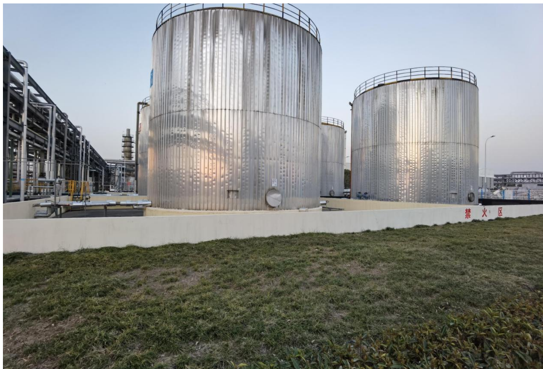
图 4.2-5 罐区围堰及内部防腐
