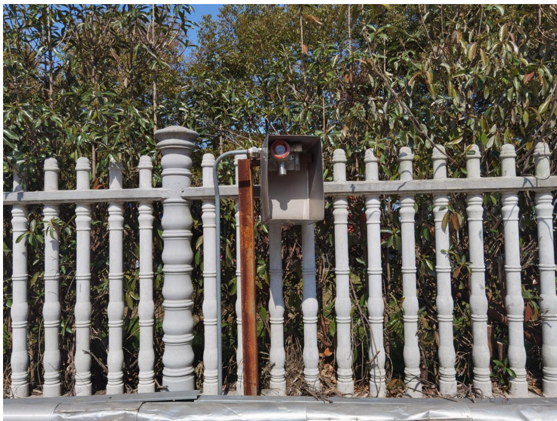
图 4.2-8 厂界 VOC 气体报警装置
