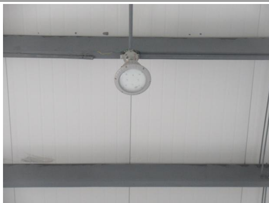
图 4.1-17 南厂区危废仓库防爆灯
