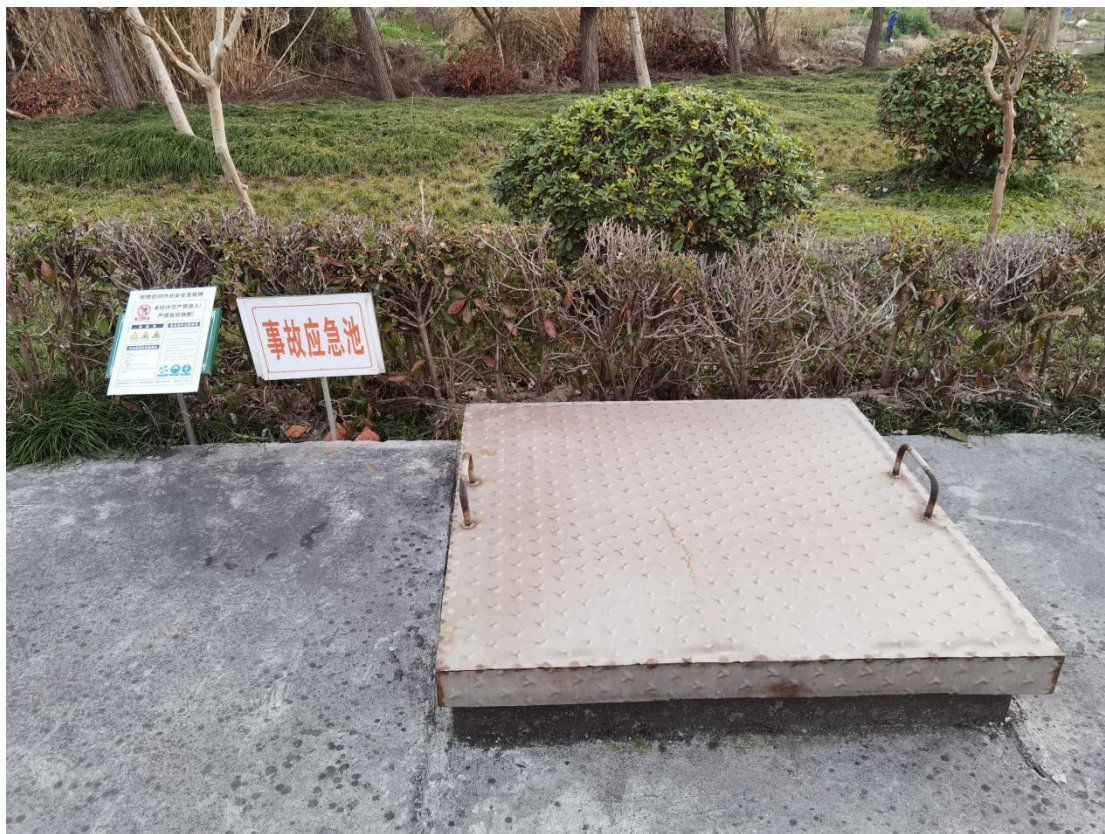
图 4.2-4 事故应急池（南厂区）
