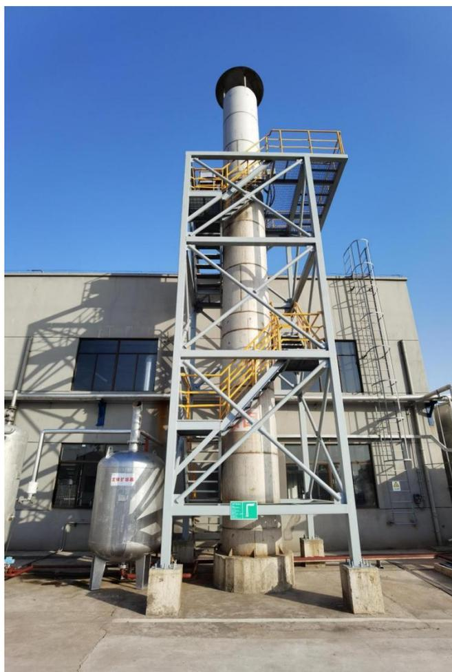
图 3-4 燃气锅炉排气筒
