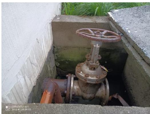
图 4.2-8 装置区雨水截止阀
